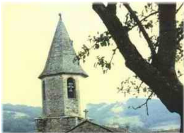
Vue du clocher, sous l'église où on voit le mieux l'inclinaison de la croix du sommet.
