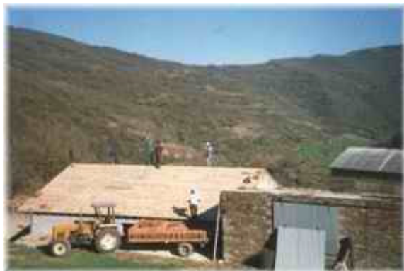
La construction de la salle.
